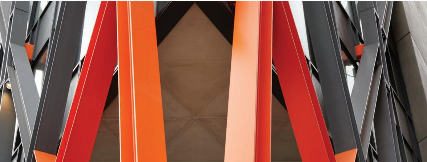
FIRETEX® FX6002 wurde entwickelt, um die kürzestmögliche Zeit von der Applikation bis hin zur Montage der Stahlbauteile für Feuerwiderstandszeiten von bis zu 2 Stunden zu gewährleisten.
