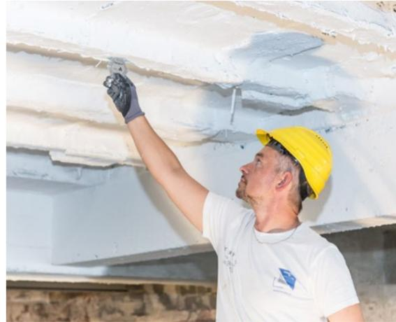
Messung der Nassfilmschichtdicke direkt nach der Applikation
