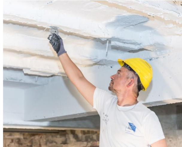
Messung der Nassfilmschichtdicke direkt nach der Applikation
