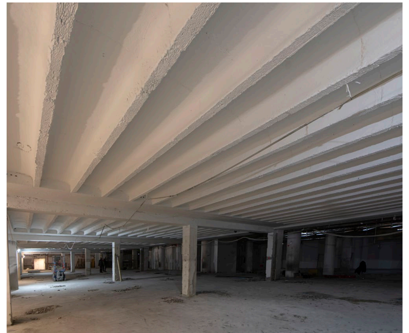
Die Applikation erfolgte im Airless-Spritzverfahren direkt auf die Betondecke
