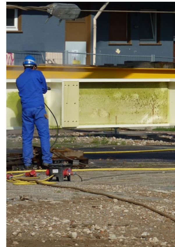
Hochdruckreinigung der Stahlträger
