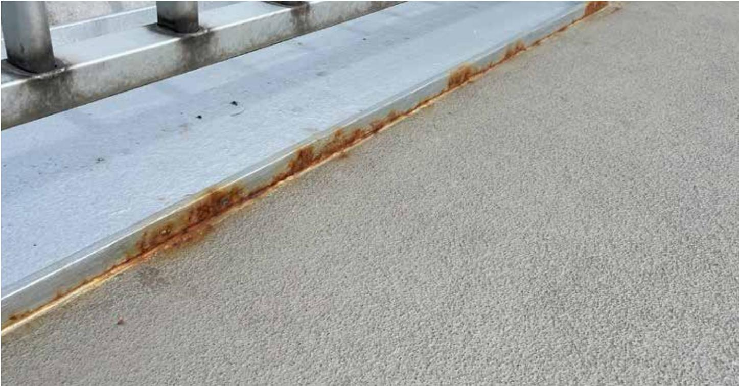
Durch Streusalz verdoppelt sich die Korrosionsgeschwindigkeit von Stahl.
