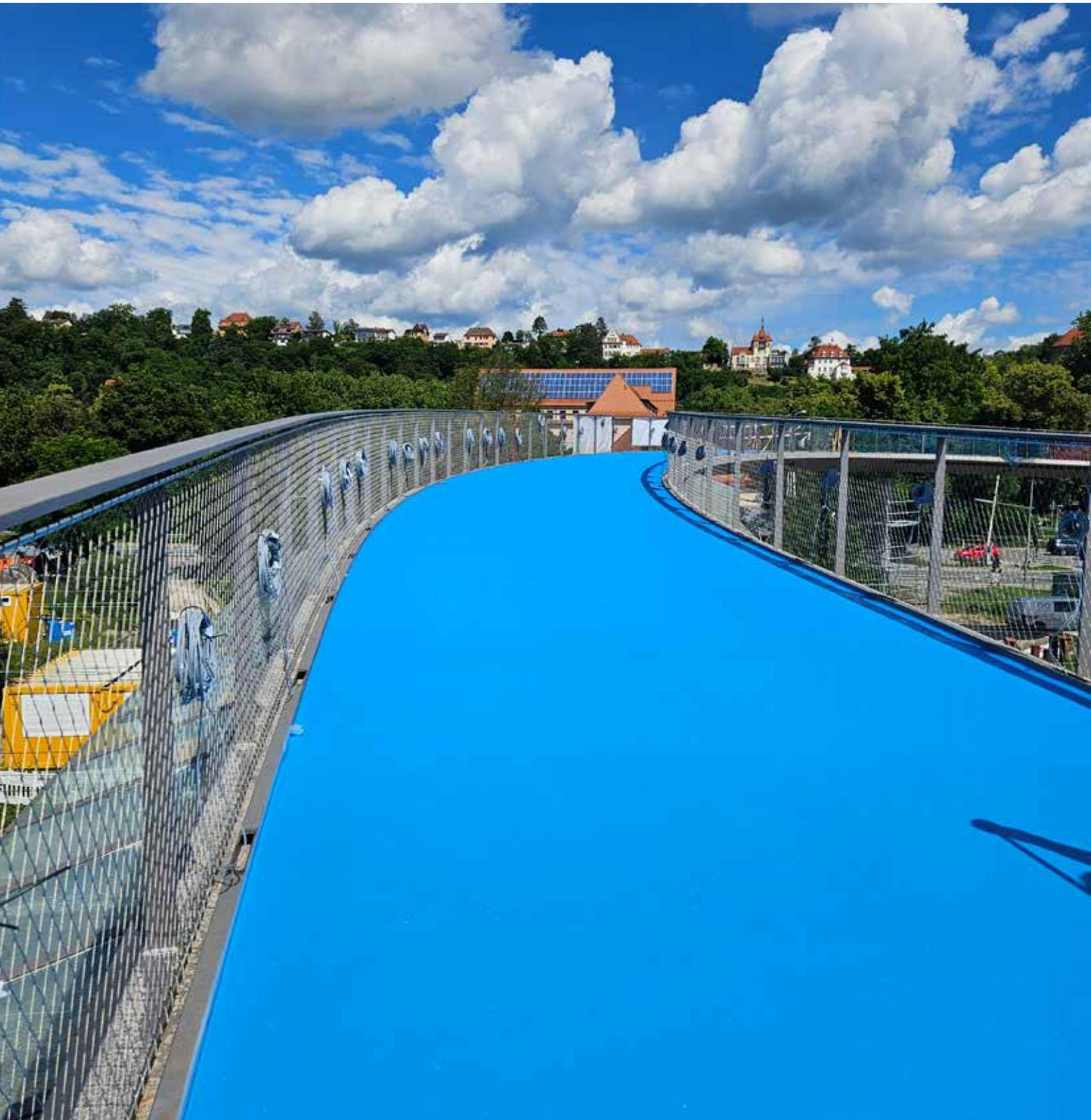
Die Radbrücke West in Tübingen mit der Acryl-Polyurethan-Kopfversiegelung im Blauton RAL 5015.
