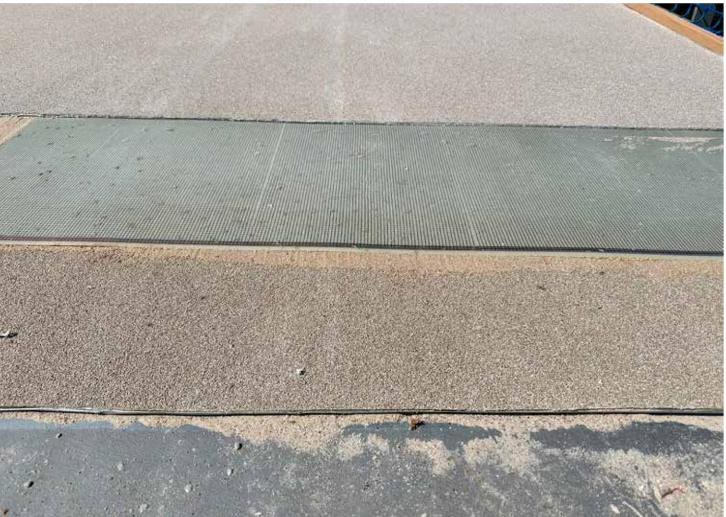
RHD-Systemaufbau einer Freiflächenheizung mit Heizelementen: Stahlbrückentafel, Grundbeschichtung Macropoxy HM Primer Plus und Zwischenbeschichtung Elastomastic TFN, STELOpreg-Heizelemente, mit Quarzsand abgestreute Deckbeschichtung Elastomastic TFN (von unten nach oben). ©
