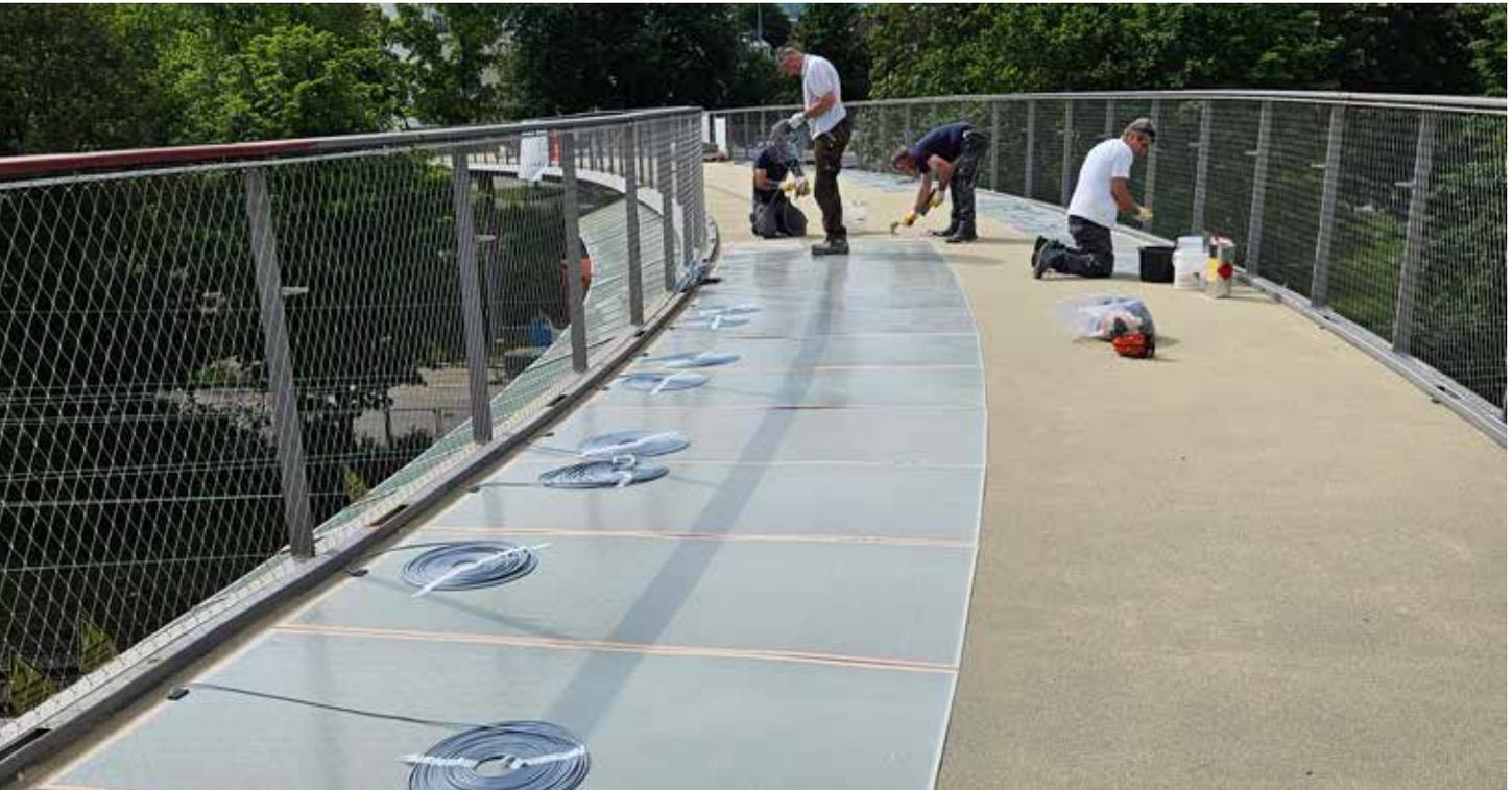
Die STELOpreg-Heizelemente werden vollflächig mit der RHD-Zwischenbeschichtung verklebt. Sie sind eine Weiterentwicklung des für Parkhäuser bewährten Systems. © Bauschutz GmbH & Co. KG
