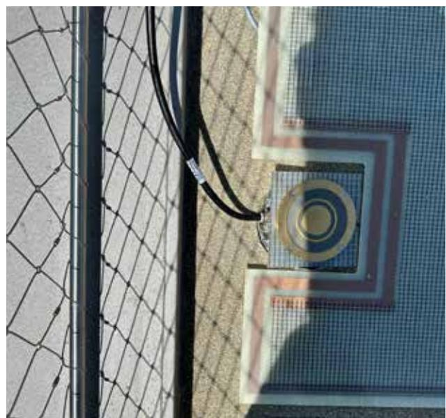
STELOpreg-Heizelement mit elektrischem Anschluss.
