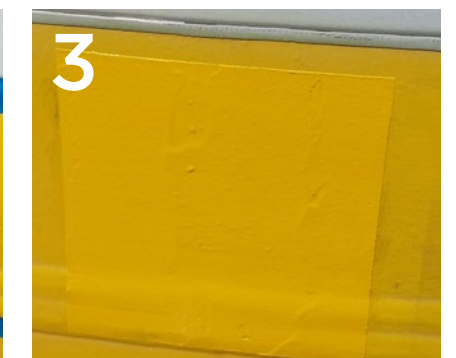
3 Reparierte Fläche, nach bereits wenigen Stunden ausgehärtet.
