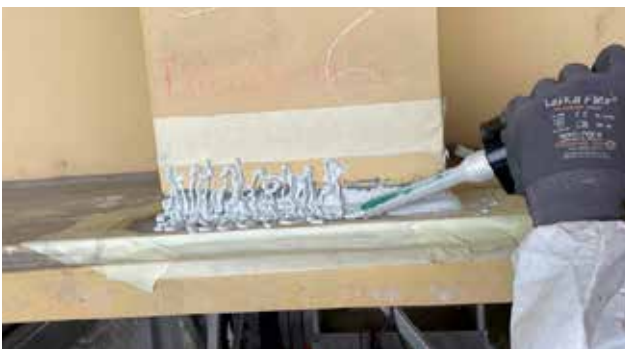
Anwendung von Repacor SW-1000 über eine Schweißnaht mittels handlicher Kartusche.
