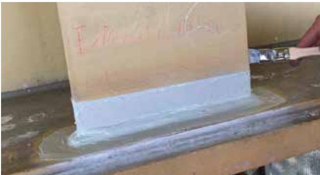
Mit Hilfe eines Pinsel wird der 2-K-Beschichtungsstoff gleichmäßig verteilt.
