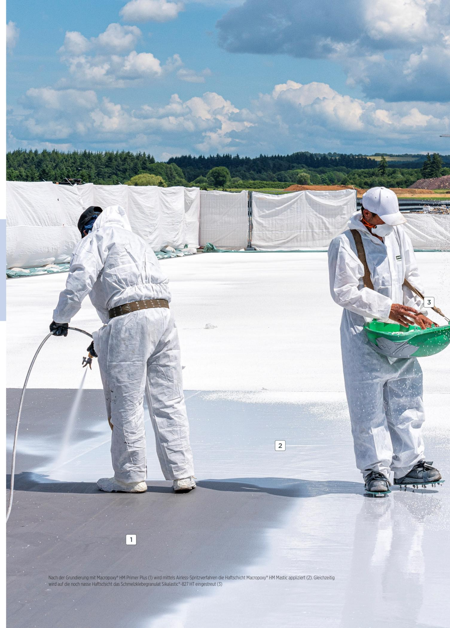
Nach der Grundierung mit Macropoxy® HM Primer Plus (1) wird mittels Airless-Spritzverfahren die Haftschrift Macropoxy® HM Mastic appliziert (2). Gleichzeitig wird auf die noch nasse Haftschrift das Schmelzklebgranulat Sikalastic®-827 HT eingestreut (3).
