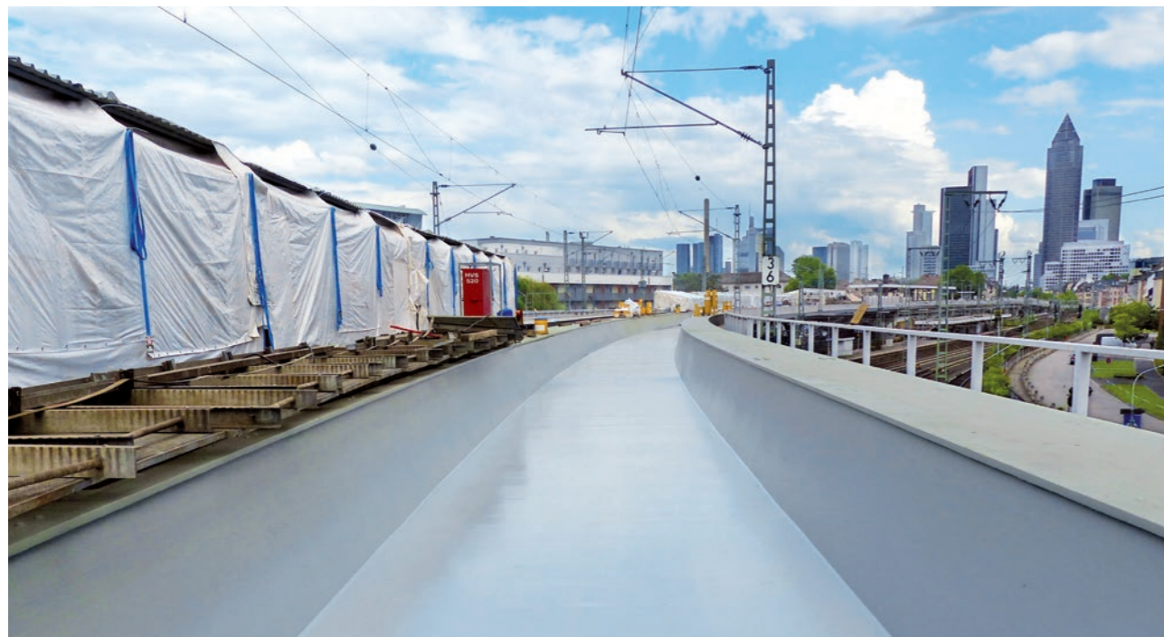
Die Sanierung der eingleisigen stählernen Schottertrogbauwerke am Bahnhof Frankfurt-West erfolgte mit einem Beschichtungsaufbau von Sherwin-Williams, welcher 2015 als erstes System die herstellerbezogenen Produktqualifikationen der Deutschen Bahn besaß
