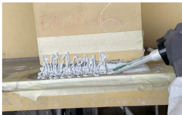
Anwendung von Repacor SW-1000 über eine Schweißnaht mittels handlicher Kartusche.
