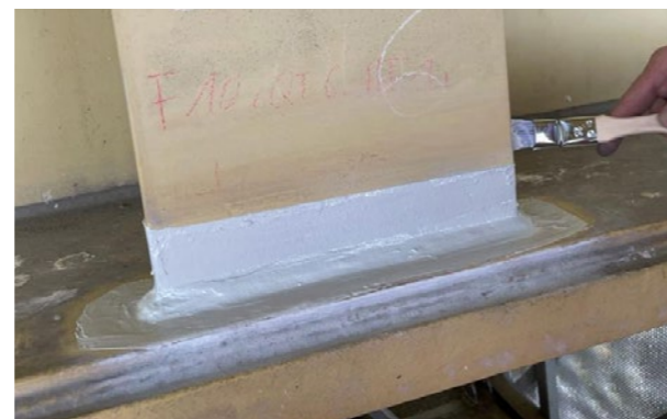
Mit Hilfe eines Pinsel wird der 2-K-Beschichtungsstoff gleichmäßig verteilt.
