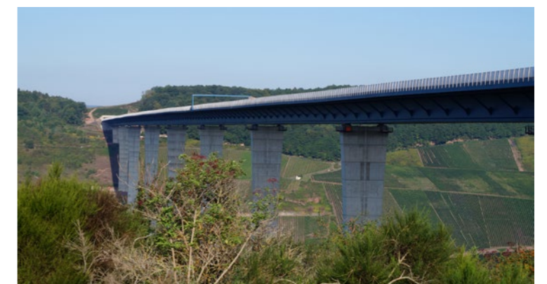
Hochmoselbrücke, Ürzig bei Wittlich (2011-2019)
