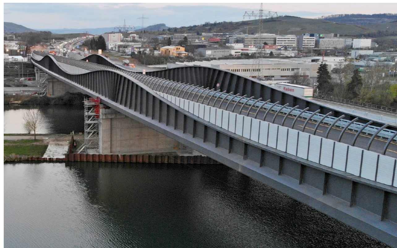
Nach Anlieferung und Montage der Stahlbauteile für die neue Neckartalbrücke der A6 bei Heilbronn erhielten die Schweißnähte einen schnellhärtenden Beschichtungsaufbau von Sherwin-Williams nach Blatt 97.
