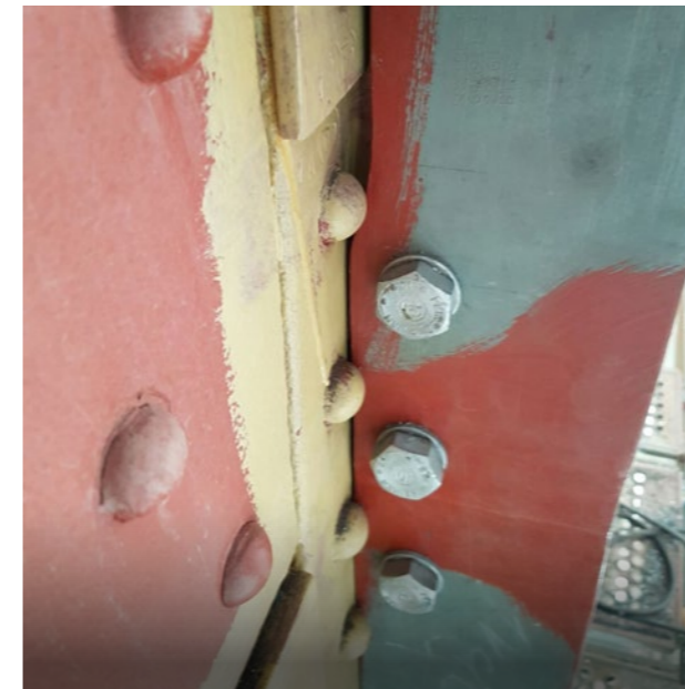
Zum Abdichten der Spalten und Nieten wurde ein Fugendichtstoff eingesetzt
