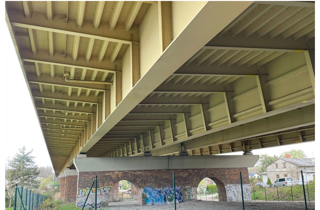
Die Mühlenfließbrücke in Brandenburg zählt ist eines von vielen Pilotprojekten für die Reparaturbeschichtung Repacor SW-1000.
