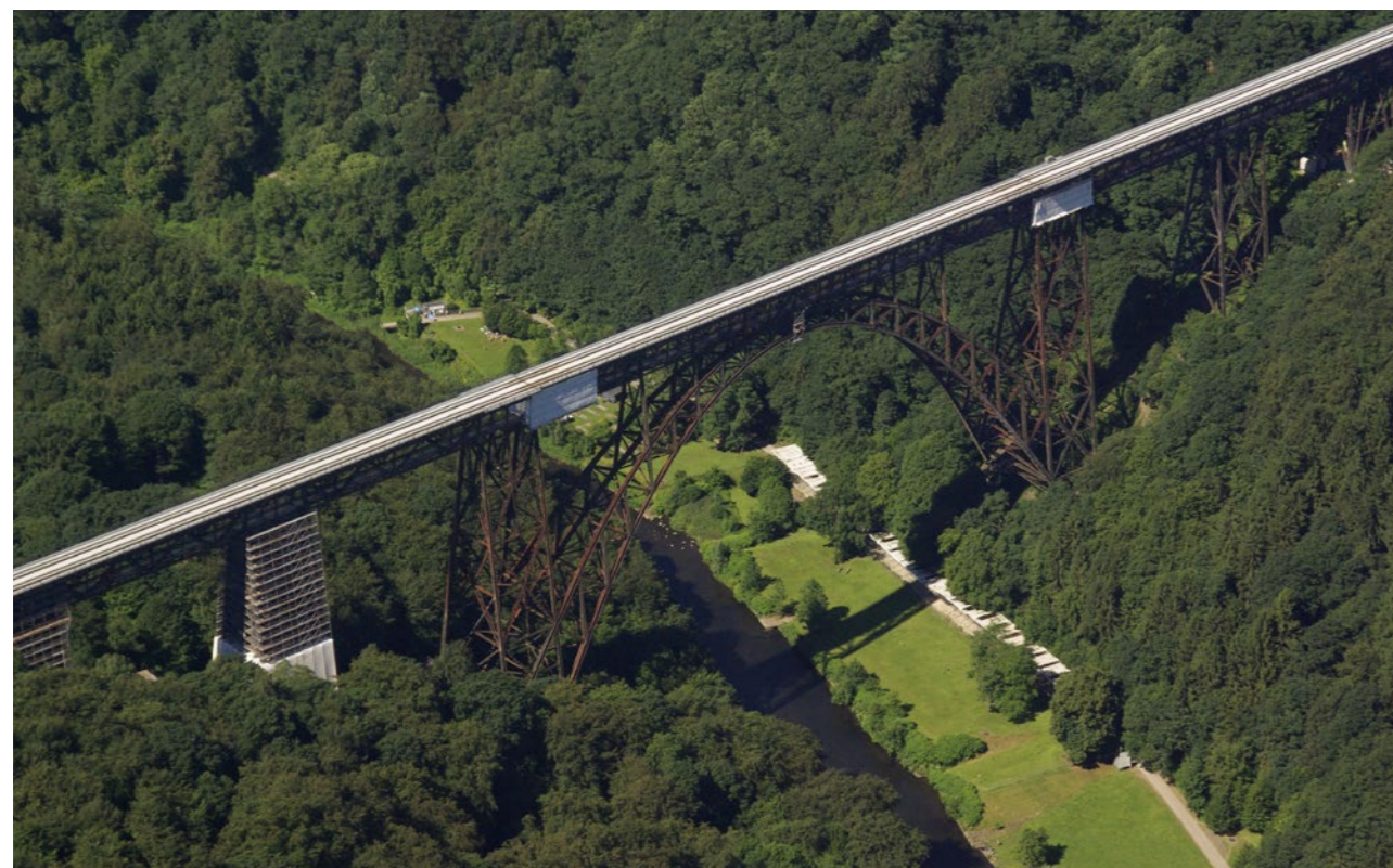
Instandsetzung der denkmalgeschützten Mungstener Brücke mit dem Sherwin-Williams-System nach Blatt 94
