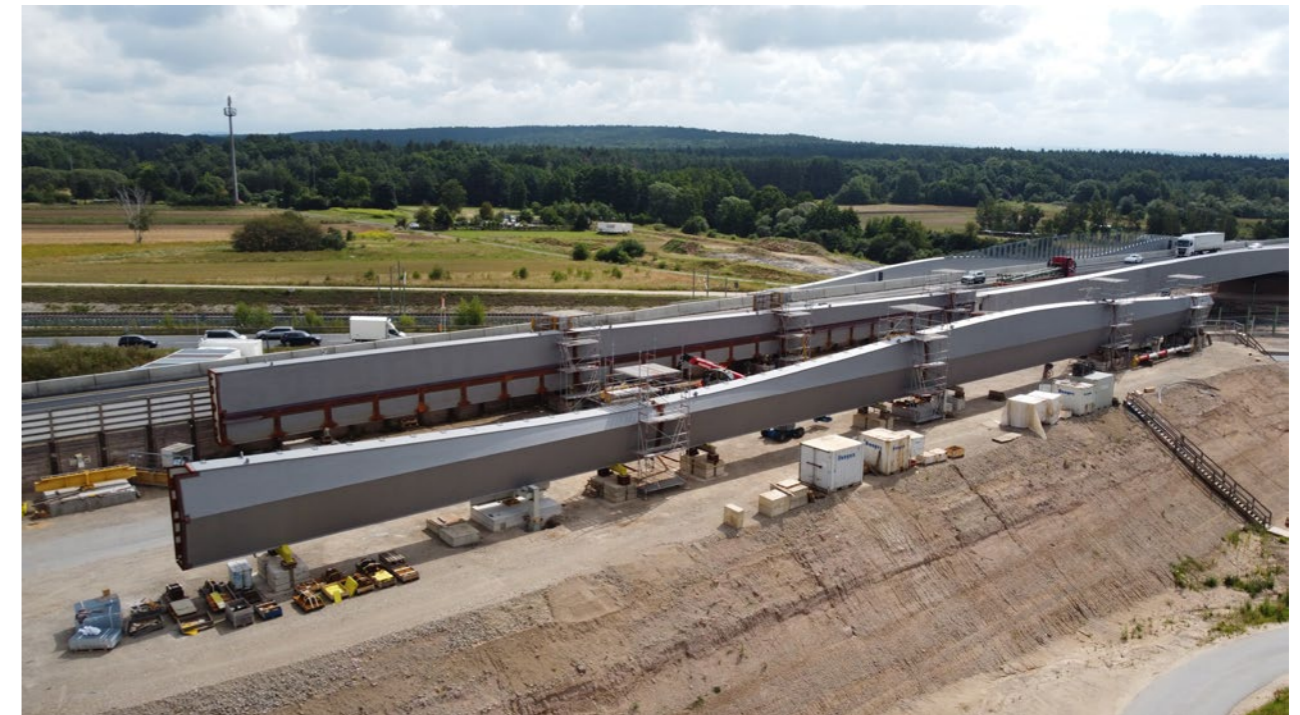
Bamberger Brücke Bau 2021
