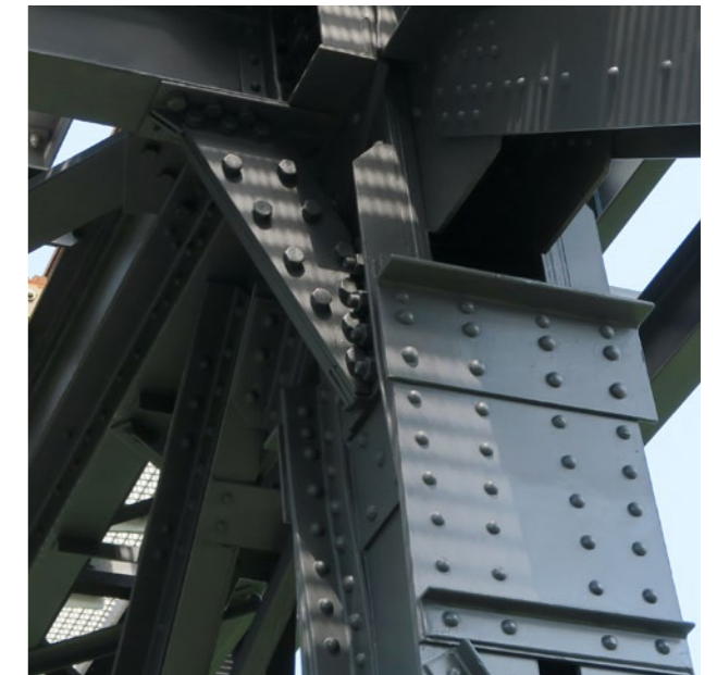
Fertiger Abschnitt: Mit der Deckbeschichtung Acrolon® EG-4 ist das historische Stahltragwerk wieder langfristig geschützt.
