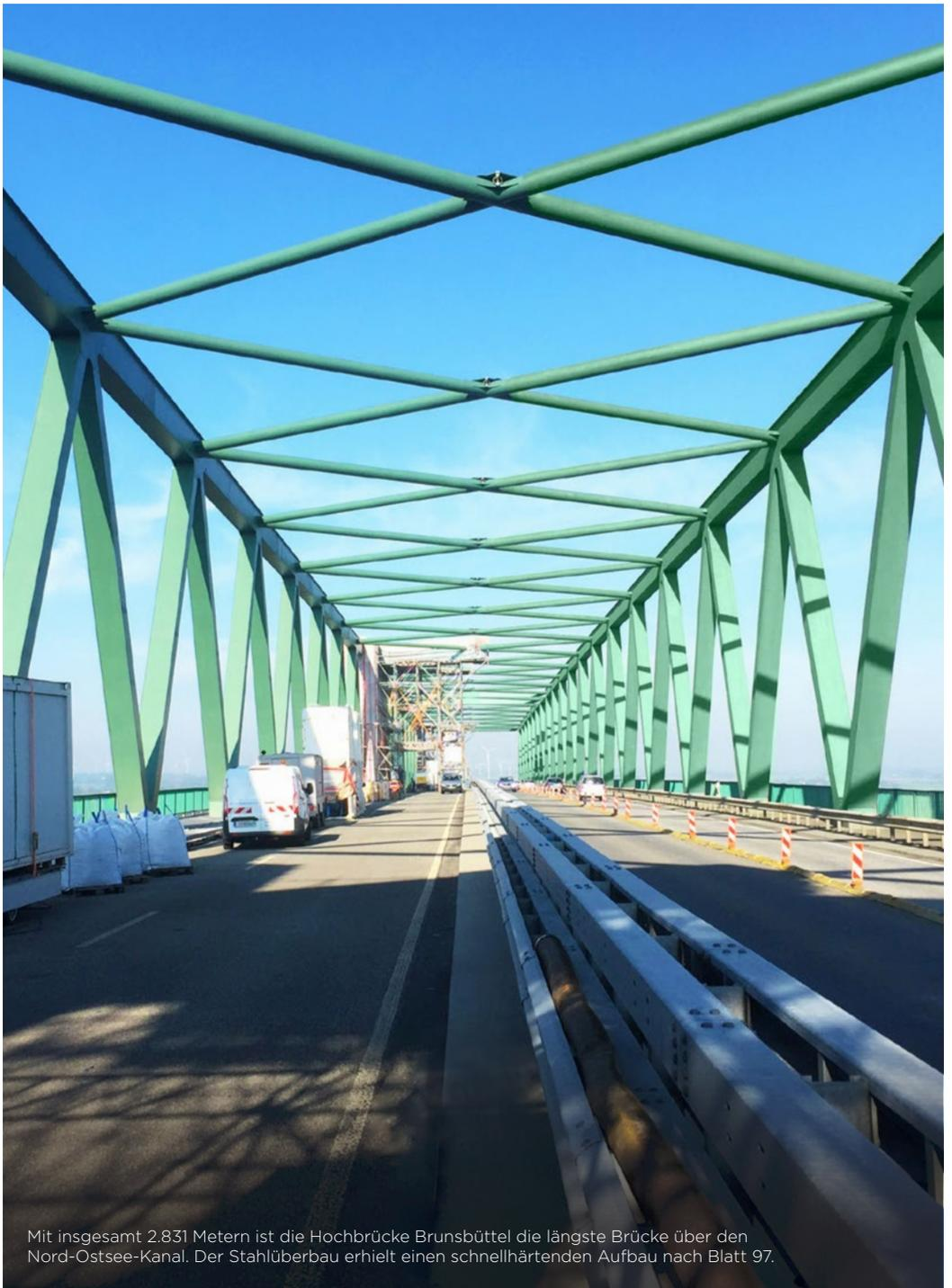
Mit insgesamt 2.831 Metern ist die Hochbrücke Brunsbüttel die längste Brücke über den Nord-Ostsee-Kanal. Der Stahlüberbau erhielt einen schnellhärtenden Aufbau nach Blatt 97.
