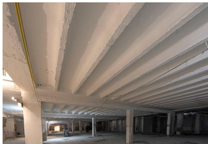
FIRETEX Concrete WB a été utilisé sur une surface d'environ 6 500 m<sup>2</sup> du Terminal 2 de l'aéroport de Vienne.
