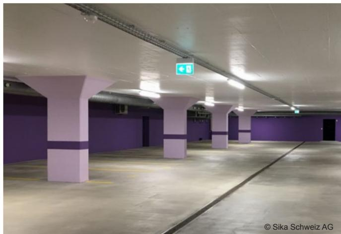
Plafonds et colonnes fraîchement rénovés avec FIRETEX Concrete WB.
