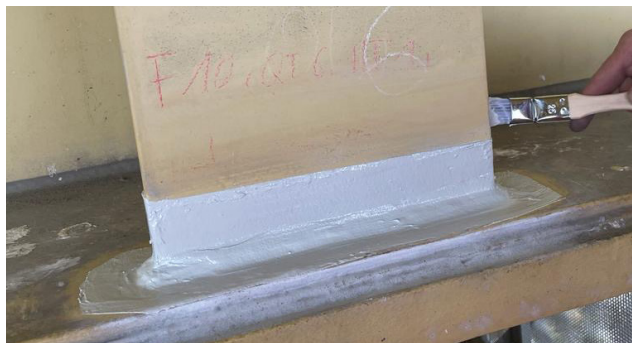
Do równomiernego rozprowadzenia dwuskładnikowej powłoki należy użyć pędzla.
