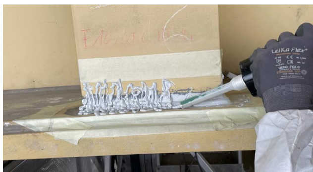
Łatwa aplikacja Repacor SW-1000 na spoinach spawalniczych dzięki poręcznemu wkładowi.
